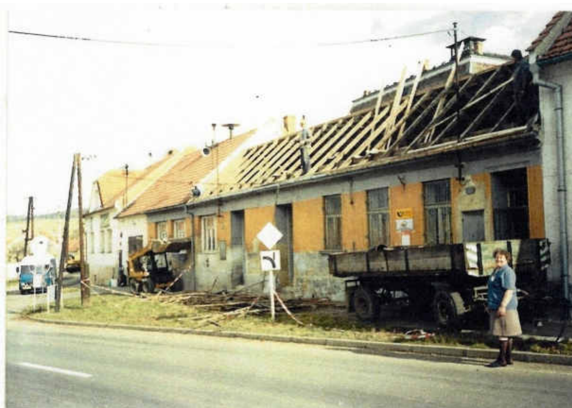
Budova pošty při rekonstrukci v roce 1995 – vpravo na snímku tehdejší poštmistrová Ludmila Leisková z Blanska
